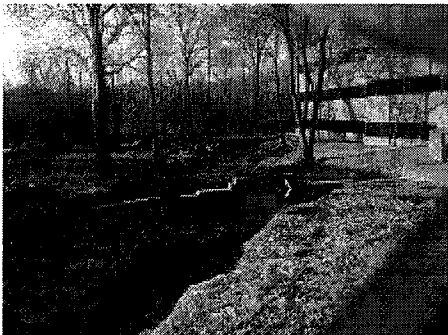
Upper Pond Dam 1.jpg 3458K
